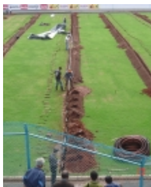
Figura 5. Inserção do geocomposto drenante e recompactação do solo retirado.
