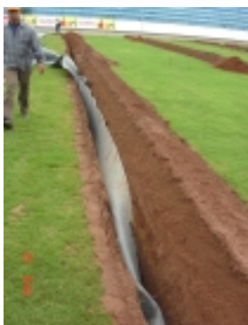
Figura 4. Durante a construção das trincheiras e inserção do geocomposto drenante.
